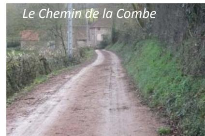
Le chemin a été repris en partie supérieure avec de la castille provenant de notre carrière des Combes, compactage pour la tenue aux intempéries. Mise en place d'un drain et d'un caniveau en bout de chemin. Reprise de la route au dessus de la buse traversant la route.
