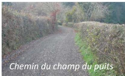
Refait sur 200 ML. L'ouvrage consiste aux renforcements de la zone de roulement par la mise en place de graviers concassés provenant de rabotage de réfection de route. Des drains longitudinaux ont été posés, des regards de visite. Les fossés améliorés. Dans la partie sous bois, reprofilage du chemin.
